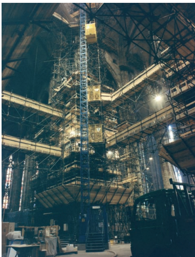
Il grandioso e tecnologico cantiere per il restauro statico dei piloni del tiburio, 1981-1984.
